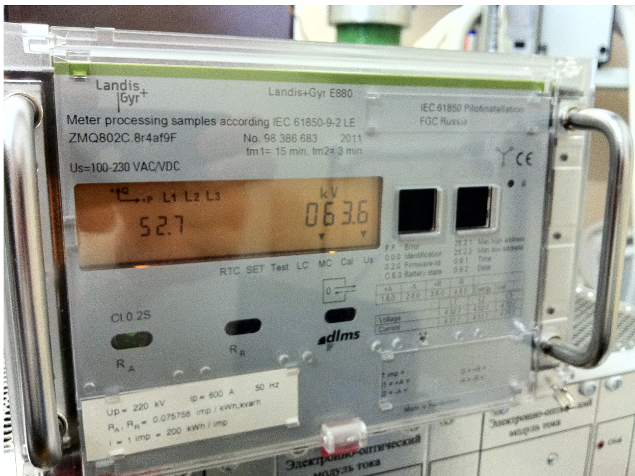
Рис. 4. Измерения напряжения, фиксируемые прибором учета электроэнергии ZMQ802C.
